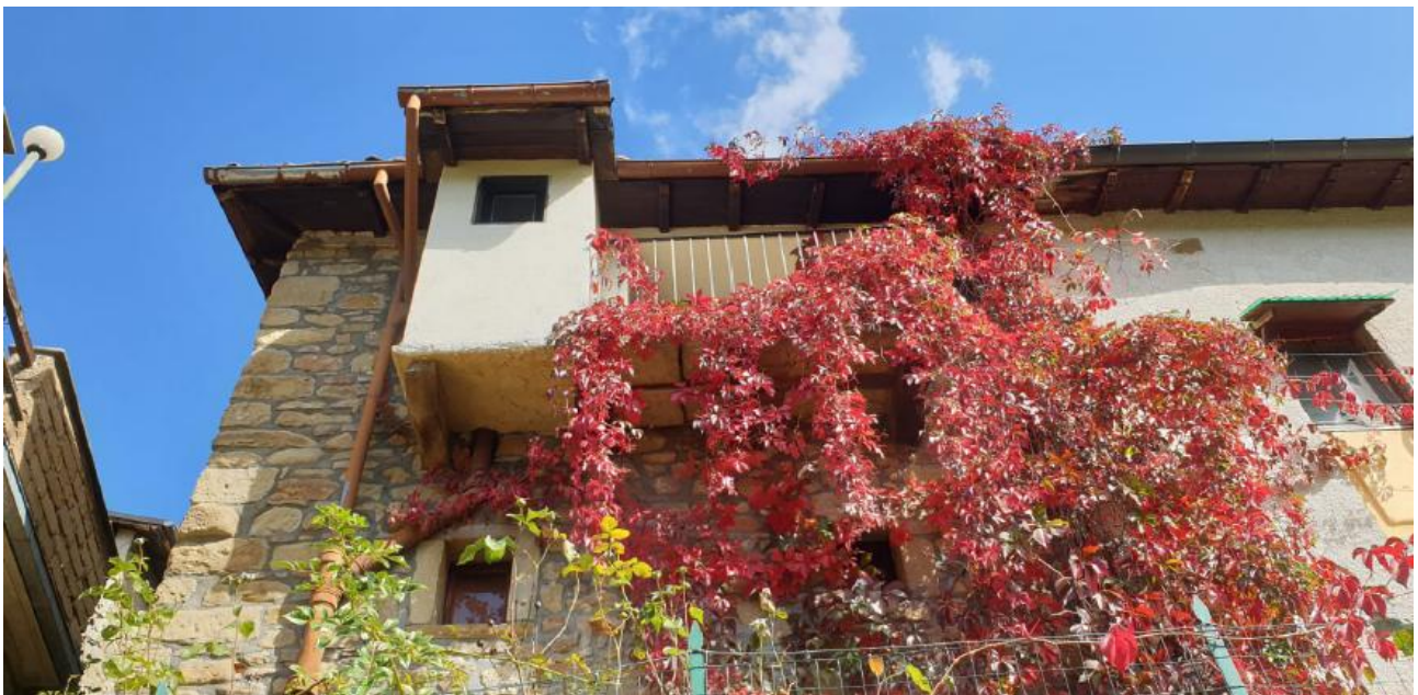
foto 56 . balcone con locale "wc"
