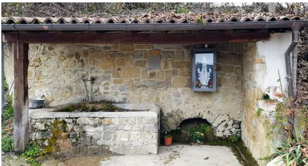
foto 32 . fonte "la trocca" dopo il terremoto del 2016.
