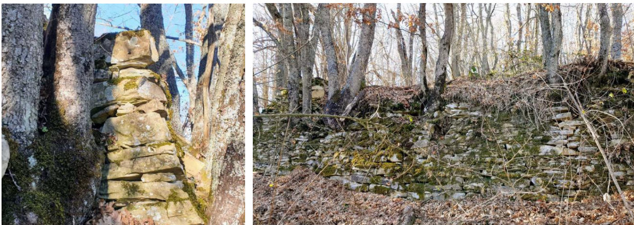
foto 35-36 . resti del muro del Castellum militare
