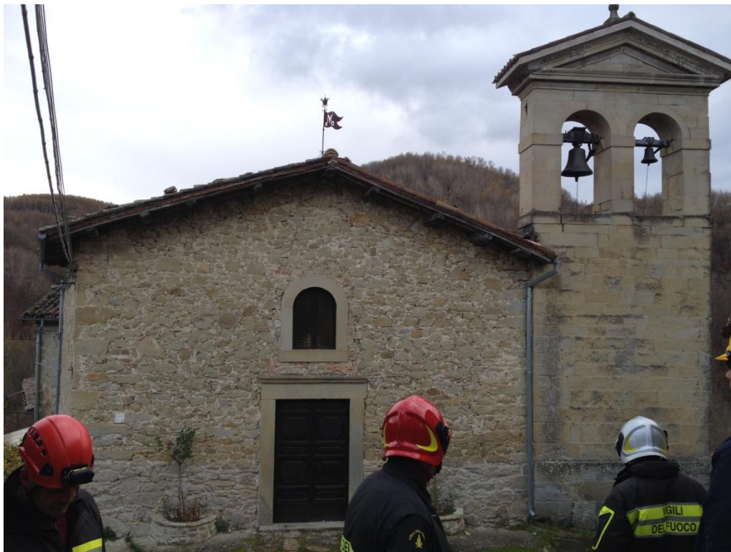
foto 27. Chiesa di San Martino dopo il terremoto del 2016
