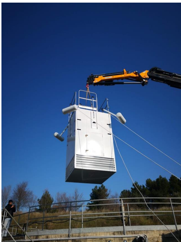
Figura 8. Foto dispositivo in fase di installazione
