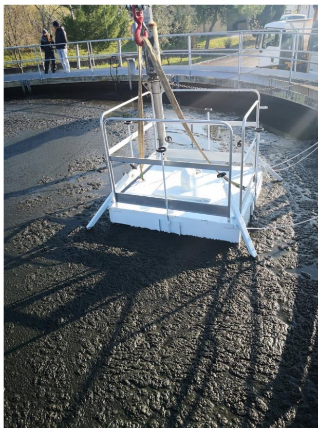
Figura 9. Foto dispositivo installato
