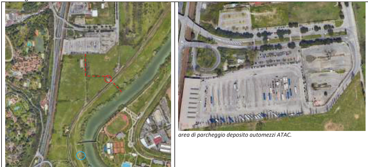
Figura 10 – scarico sollevato di acque bianche (gestione ARDIS) provenienti dal parcheggio – capolinea automezzi Cotral. La linea rossa evidenzia il percorso, il cerchio l'impianto di sollevamento.
