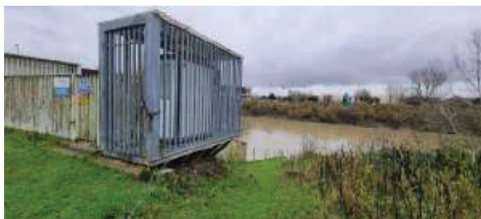
Figura 1 – vista laterale della recinzione
