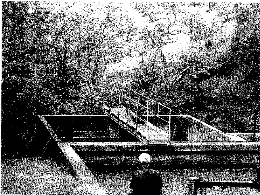
FOTO 10 – Sedimentazione secondaria (via Coste)
