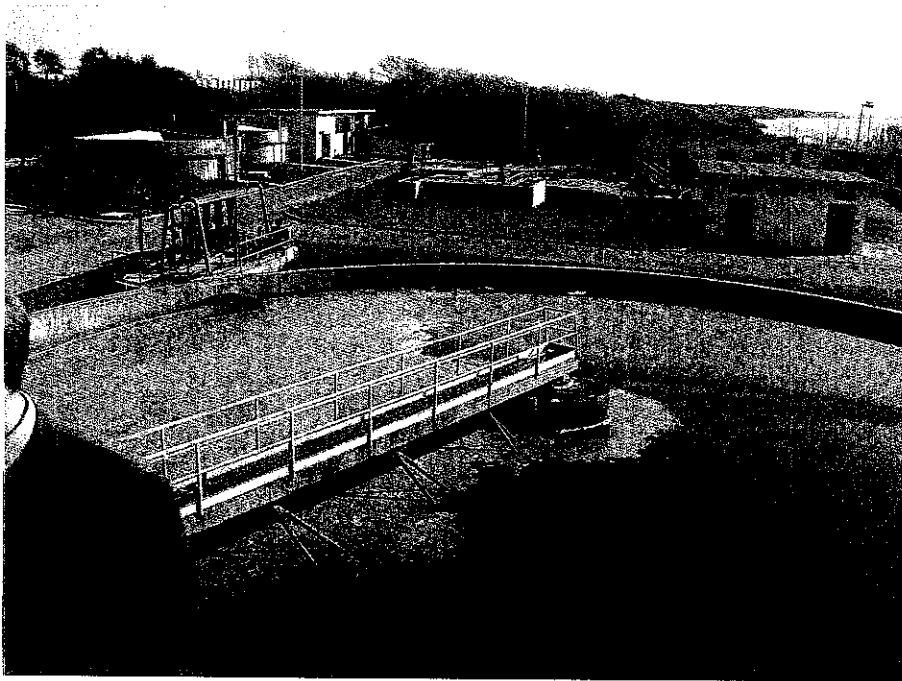
FOTO 36 – Sedimentazione secondaria
