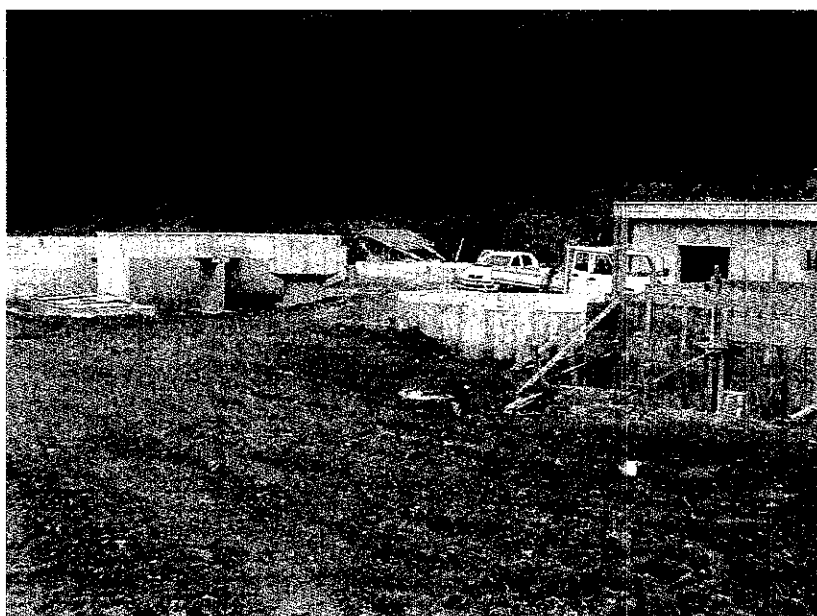
FOTO 23 – Nuovo Impianto – visione d'insieme
