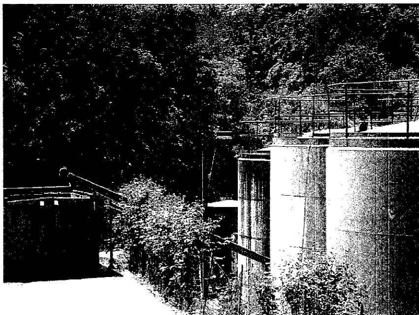
FOTO 20 – Impianto esistente – visione d'insieme
