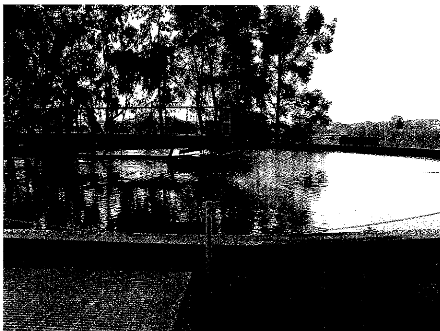
FOTO 26 – Sedimentazione secondaria
