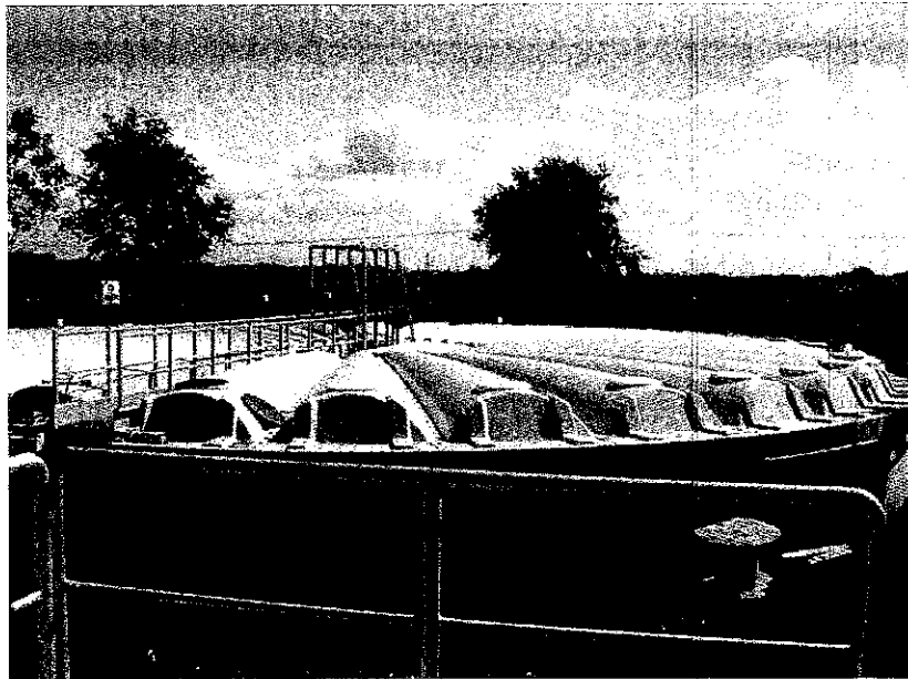
FOTO 32 – Sedimentazione secondaria
