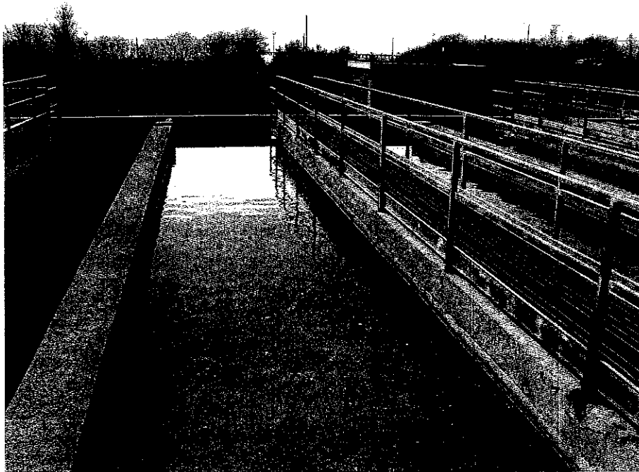
FOTO 3 – Sedimentazione primaria vasca Imhoff
