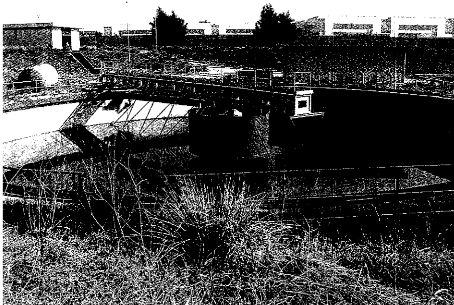
FOTO 49 – Sedimentazione primaria
