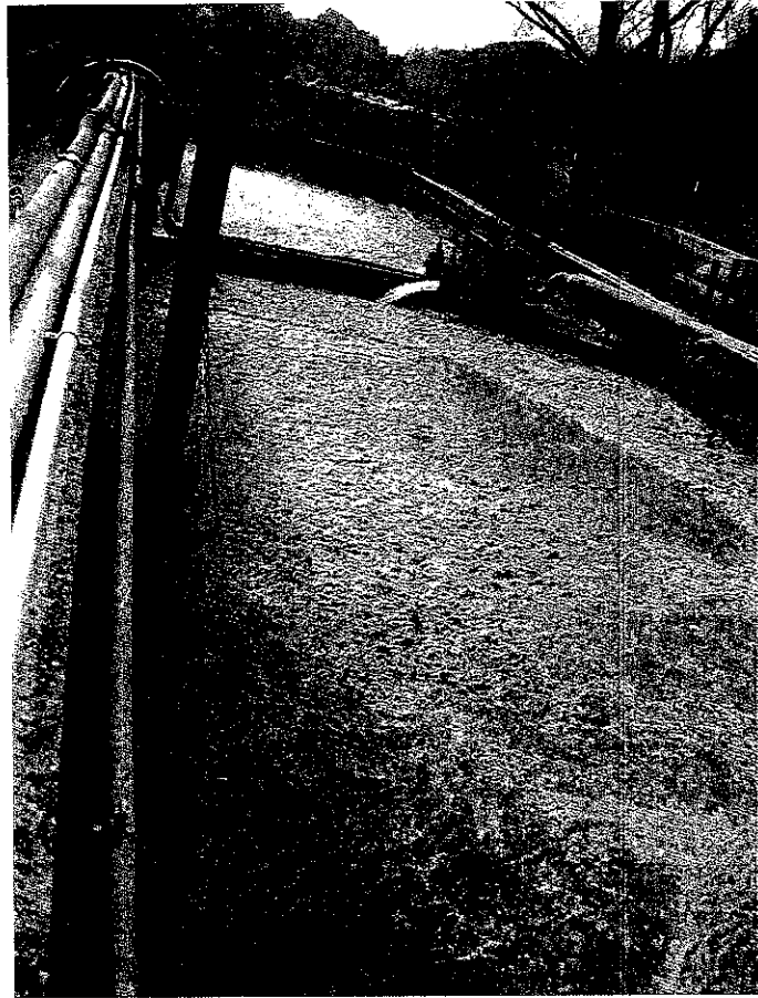
FOTO 16 - Vasca di nitrificazione
