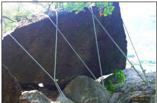
Figura 7\_ Esempio di messa in sicurezza di blocco roccioso con chiodature e imbragature
