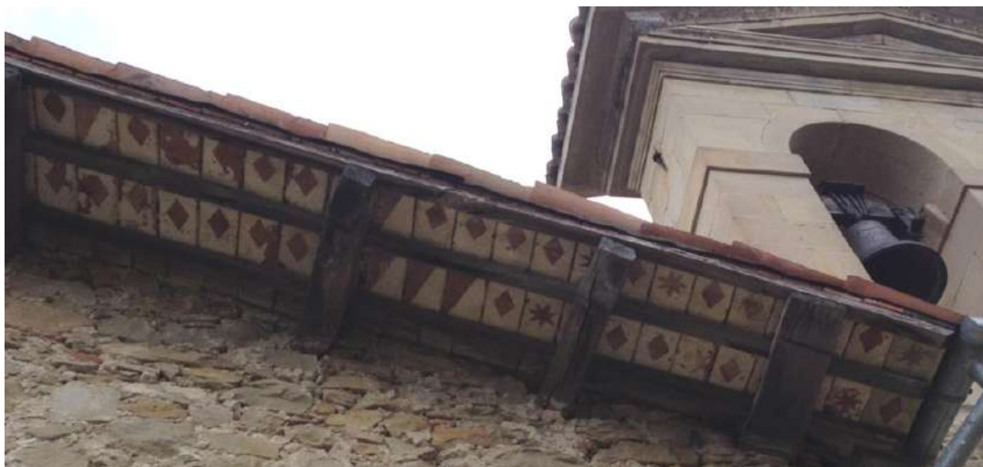
fig. 57: pianelle impiegate all'intradosso dei tetti
