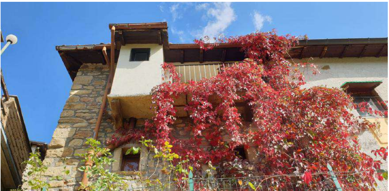
fig. 56: balcone con locale wc
