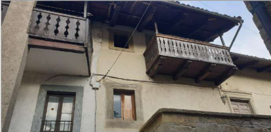
fig. 49: sporti lignei lungo il corso del borgo, ancora presenti nelle case anche dopo le scosse del terremoto del centro Italia (2016)
