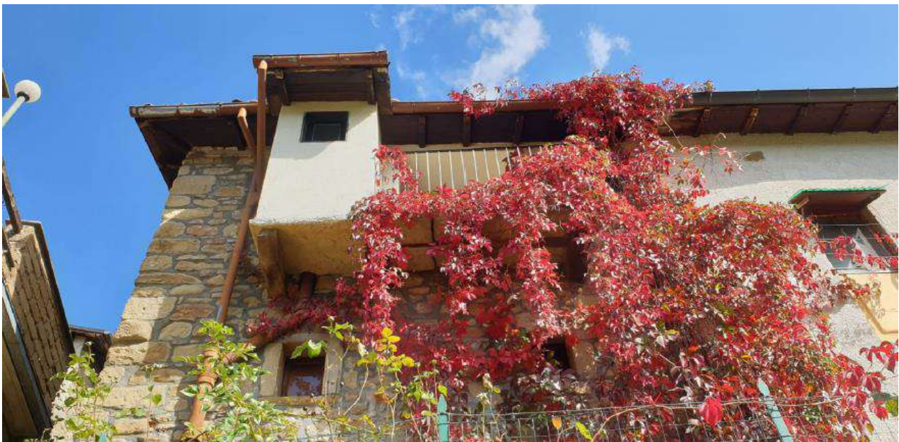
fig. 56: balcone con locale wc
