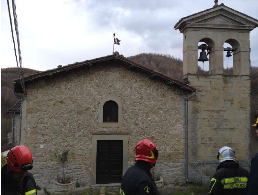
fig. 27: Chiesa di Santa Maria Assunta dopo il terremoto del 2016
