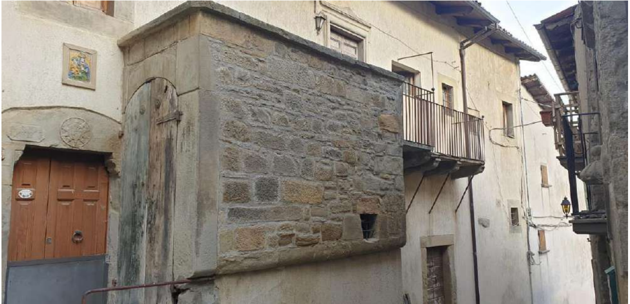
fig. 26 : vedute lungo il corso del borgo. La foto è stata scattata dopo il terremoto del 2016
