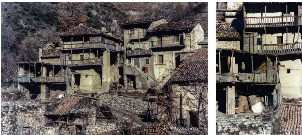
figg. 51-52: sporti lignei presenti nei centri storici del comune di Arquata del Tronto (AP)
