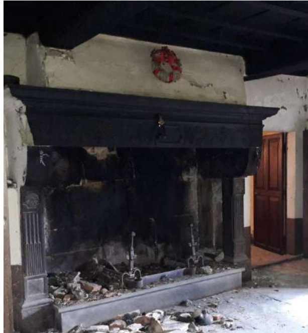
fig. 33: camino all'interno dell'ex oratorio dei cappuccini che non ha subito nessun danneggiamento dalle scosse del terremoto del 2016
