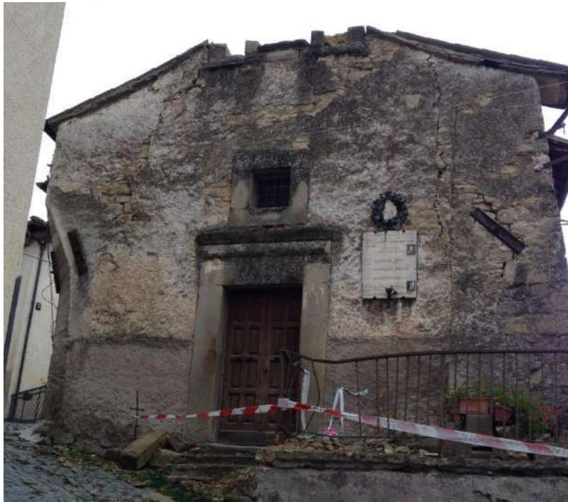
fig. 29: Chiesa di San Martino dopo il terremoto del 2016. Le scosse del terremoto hanno fatto crollare il campanile a vela posto in asse con il portale. Il sistema di catene e tiranti, già presente nella chiesa, ha evitato altri gravi danneggiamenti.
