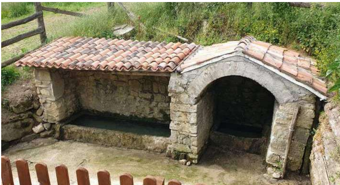
fig. 31: "fonte vecchia" dopo il terremoto del 2016.
