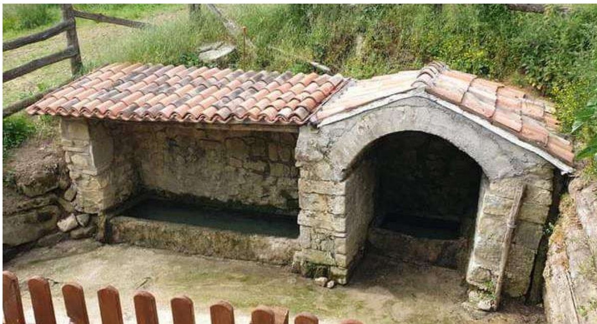
fig. 31: "fonte vecchia" dopo il terremoto del 2016.
