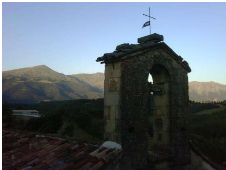
fig. 59: Campanile della chiesa di di Santa Maria Assunta in Cielo, crollato dopo il terremoto del 2016
