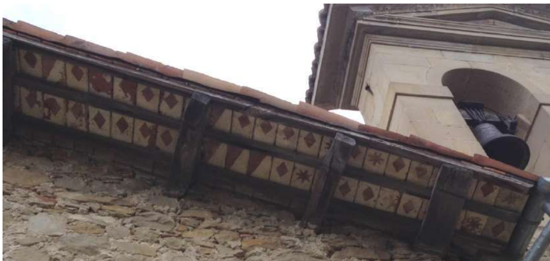
fig. 57: pianelle impiegate all'intradosso dei tetti
