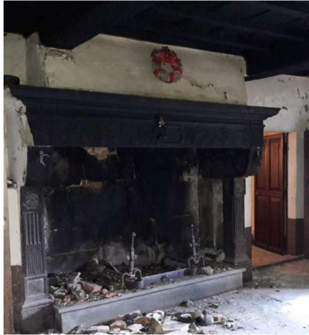
fig. 33 : camino all'interno del palazzo della famiglia Cecchini che non ha subito nessun danneggiamento dalle scosse del terremoto del 2016
