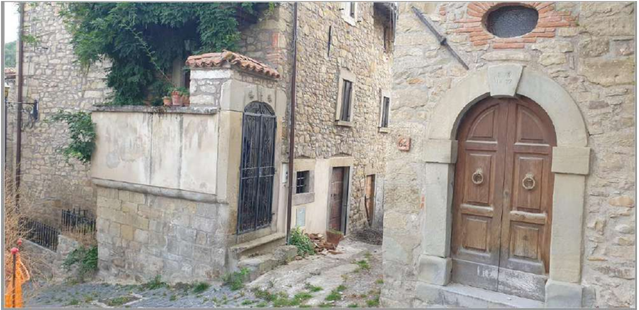
fig. 6: strade del borgo dopo il sisma del 2016
