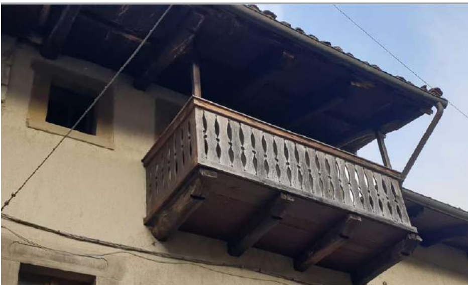
fig. 50: sporti lignei lungo il corso del borgo. Foto del 2022
