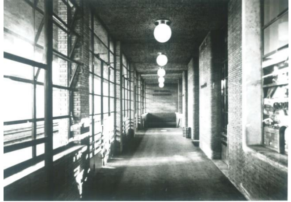
Corridoio interno alla stazione
