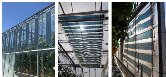
Figure 1 Pannelli fotovoltaici semi-trasparenti ed organici installati a Nantes in Francia (Fonte: en.asca.com)
