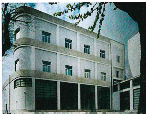
Figura 7. Pre-interventi Edificio B
