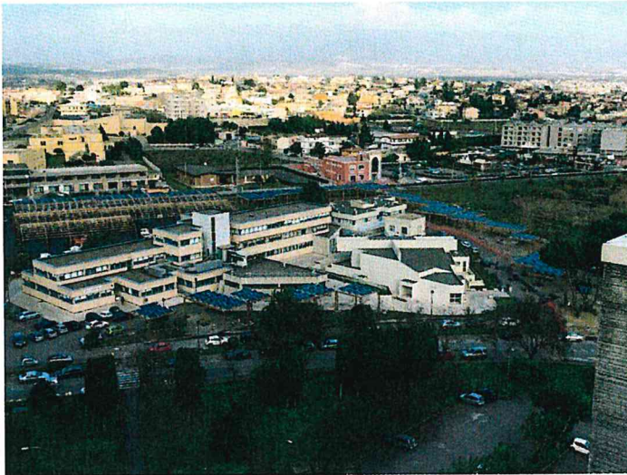
Figura 1. Impianto PV dell'ospedale Brotzu di Cagliari
