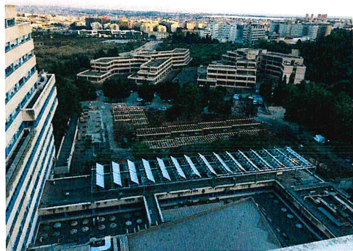
Figura 2. Impianto solare termico dell'ospedale Brotzu di Cagliari
